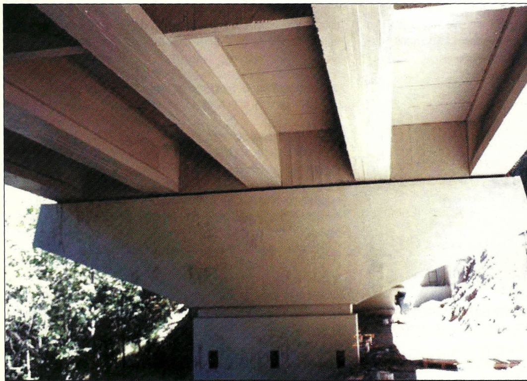
Figura 6 - Un dettaglio dell'intervento completato sull'intradosso
